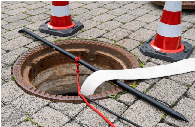
Hochhängen der Tauchmotorpumpe mittels Brechstange
