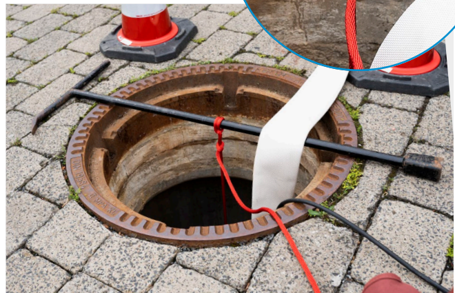
Hochhängen der Tauchmotorpumpe mittels Unterflurhydrantenschlüssel
