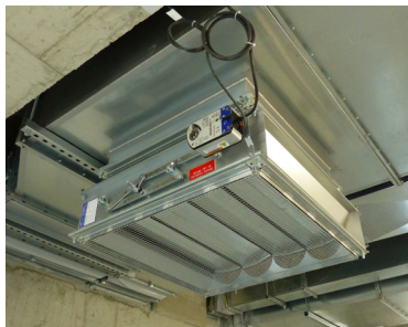
Abb. 2 und Abb. 3 Rauchabzugstaster und Rauchabzug im Gebäude
