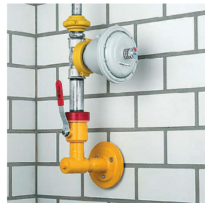
Bild 6: HAE innerhalb des Gebäudes
