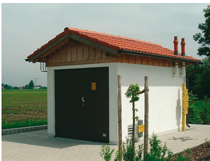
Bild 4: Gas-Druckregel- und Messanlage in Gebäudegröße außen und innen
