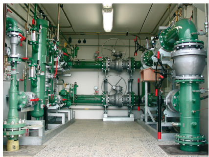
Bild 4: Gas-Druckregel- und Messanlage in Gebäudegröße außen und innen
