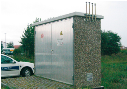
Bild 3: Gas-Druckregel- und Messanlage in Schrankgröße außen und innen
