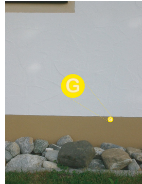
Bild 5: Kennzeichnung der Einführungsstelle der Hausanschlussleitung
