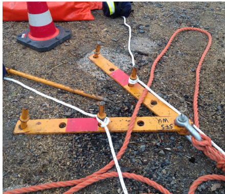
Abb. 14 und 15 Befestigung am Baum und Erdanker
